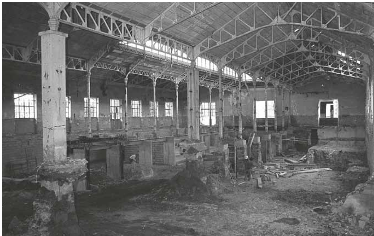
Fondation nef ouest
